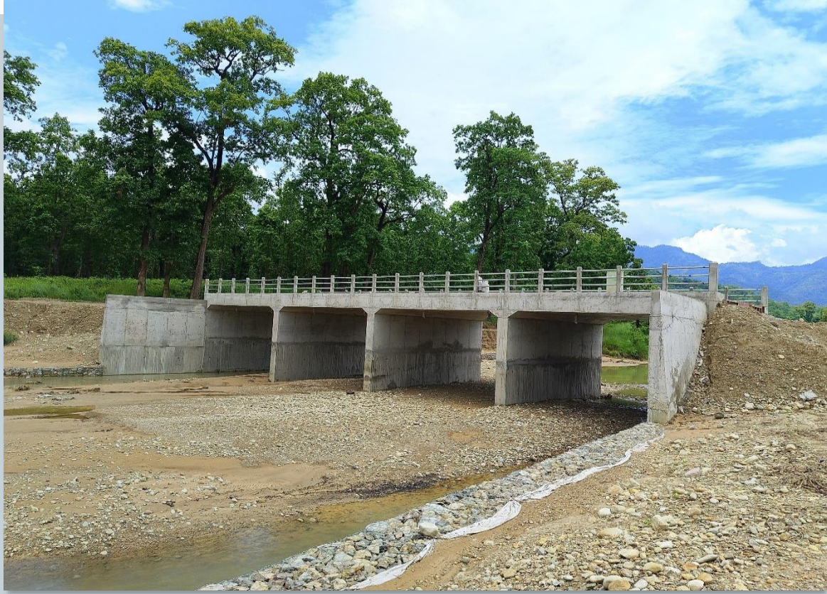
सोमनाथ खोला पुल (तिलकनाघाट र सितलपानी पुल सहित), सुनवल 6 तिल्कहना विसासय जोडने सडक, नवलपरासी (ब.सु.प.) (4x7x5m Box)
