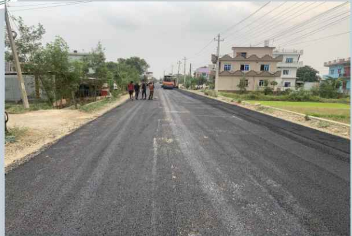
प्रेमनगर-टिकाभवन सडक, रुपन्देही
