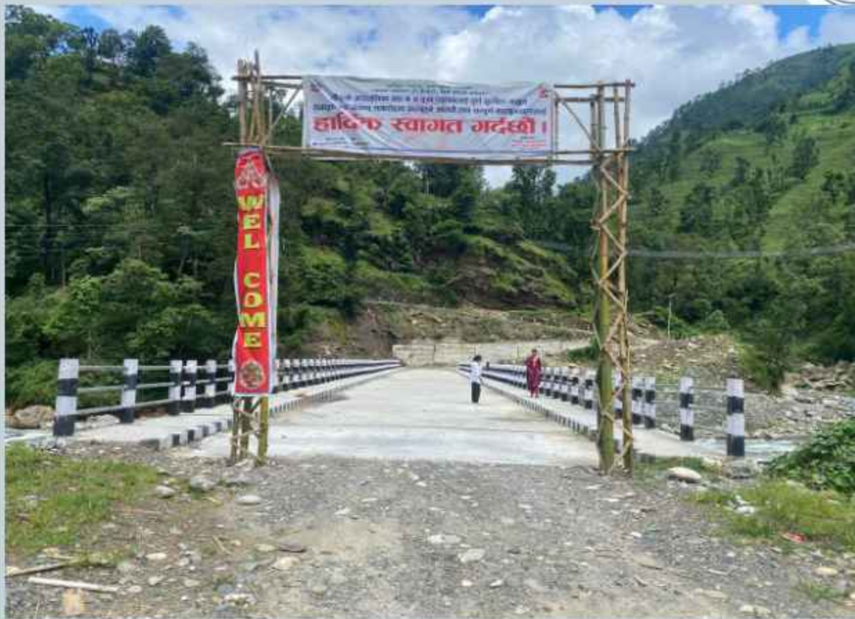
झिमरुक खोला (मसानेघाट) पुल, प्यूठान
