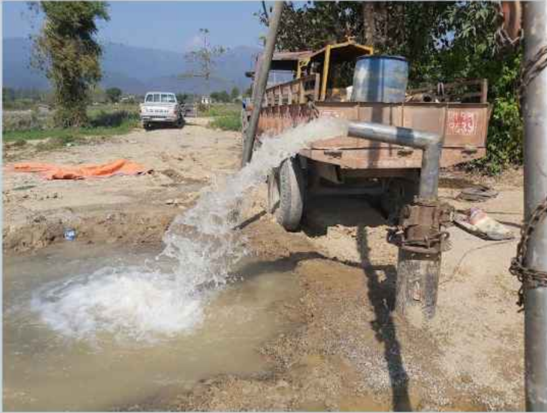
डिप ट्युबवेल निर्माण पश्चात वेल डेभलपमेन्ट कार्य बाणगंगा ९ पश्चिम जिनुवा कपिलवस्तु
