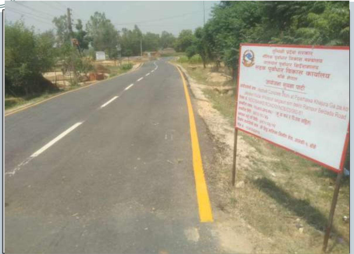
पिप्रहवा खजुरा रामपुर बेलडाँडा सडक, बाँके
